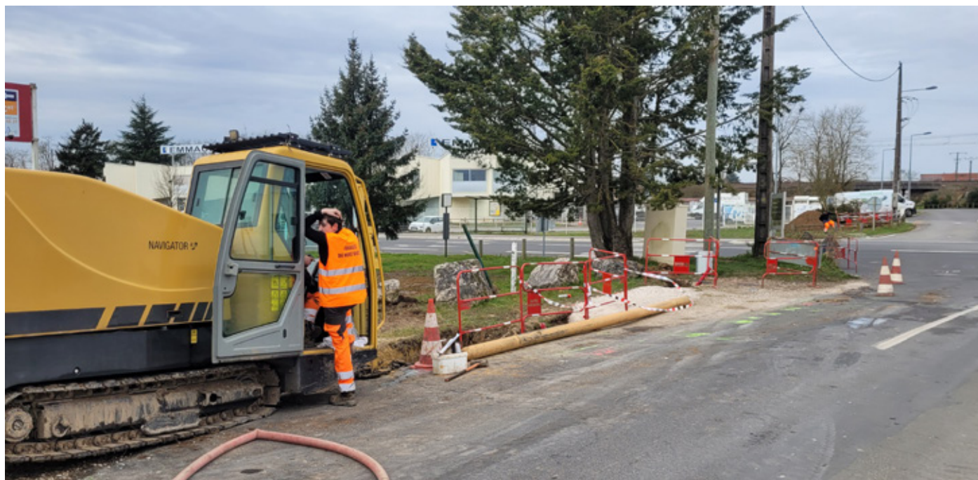
Enfouissement des réseaux rue de la Loire
