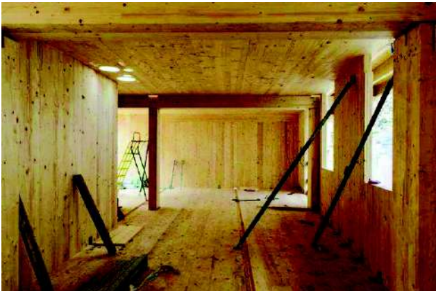
Logements structure bois
