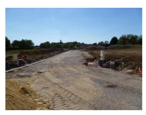
La mise en place des différents réseaux se poursuit tout à fait normalement malaré l'importance de la roche en sous-sol. Ainsi, les installations pour les eaux usées, les eaux pluviales, l'eau potable, le gaz, l'électricité, les télécommunications et l'éclairage public sont déjà enfouies.
